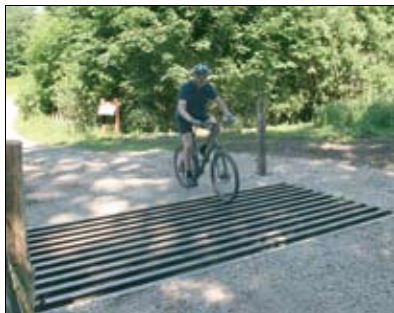
Færist. Færiste udføres, så de passer til forholdene på stedet
