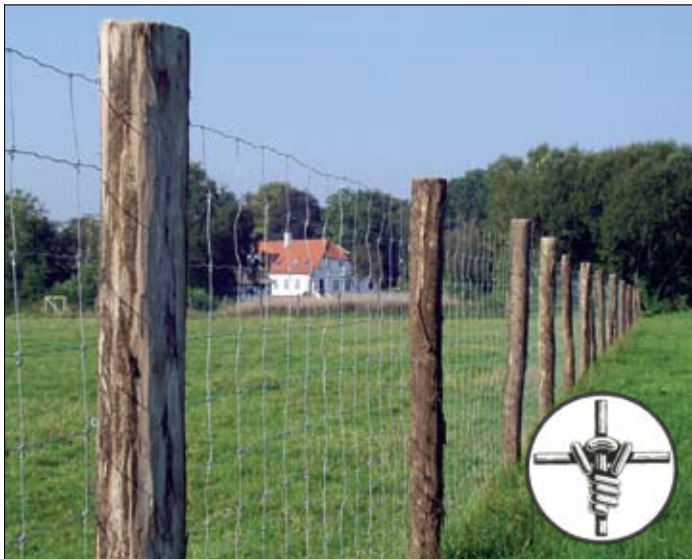
Poda Supernet på Poda Økopæle. Bemærk Supernet-knuden
